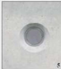
5 Uzavření distanční trubky s kuželem
