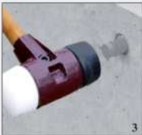
3 Zatlučte STOPPER gumovým kladivem
