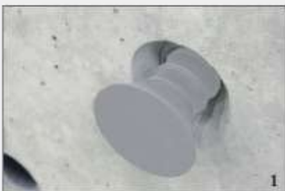
1 Uzavření kuželového otvoru
