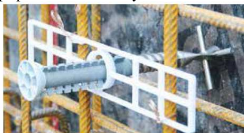
V případě vnitřního bednění, sloupu nebo ocelového bednění se pomocí výztužné desky připevní kotva na výztuž.
