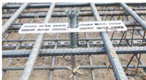
Při použití na stropní nebo podlahové panely je nerezová kotva V2A UNI připevněna k horní výztuži pomocí montážní desky.
