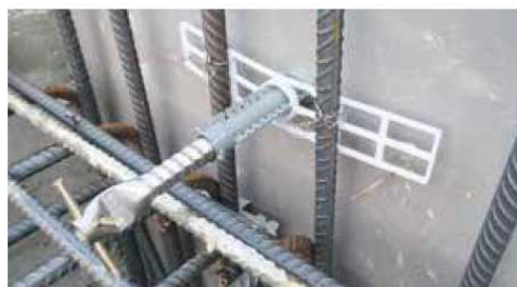
Kužel je pomocí montážní desky optimálně přitlačen k bednění.
